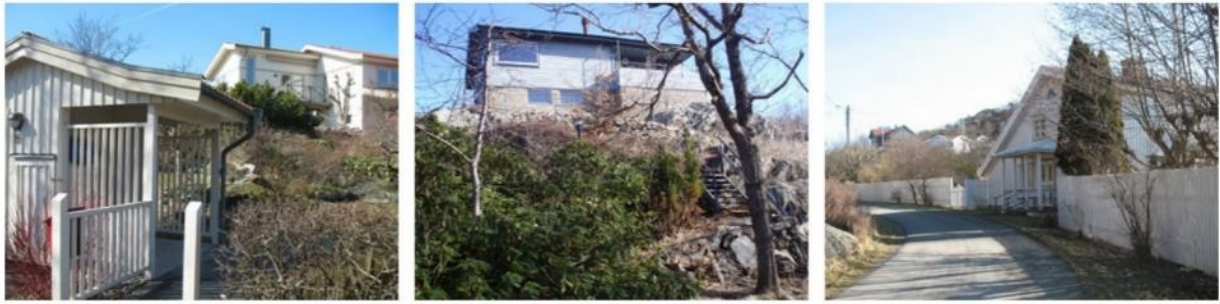
Figur 5. Befintlig bebyggelse på Brännö 5:47, 4:172 och 1:44 (Langegården).
